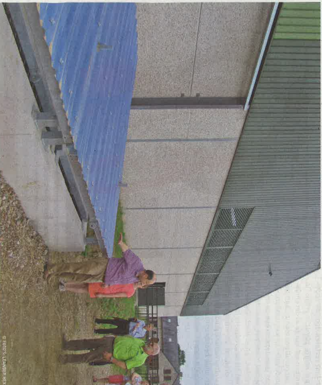
Jean-Pierre Van Puymbrouck toont de fytobak, waarin hij spoel- en restwater van gewasbescherming verwerkt.
